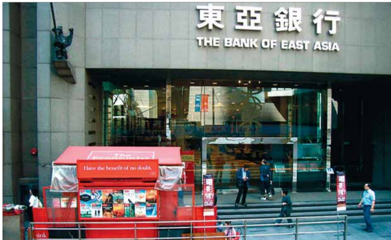
Instal·lacions centrals del Bank of East Asia, a Hong Kong ■ ARXIU
