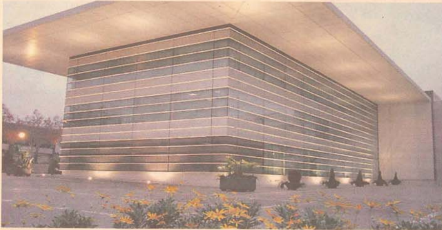
Nueva sede central de Caixa Laietana en Mataró.
