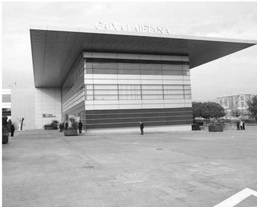
Imatge de la seu dels serveis centrals de Caixa Laietana a Mataró. / QUIM PUIG
